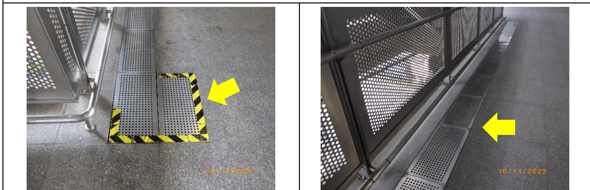
รูปที่ 2-17 รางระบายน้ำบริเวณสถานีรถไฟฟ้า
